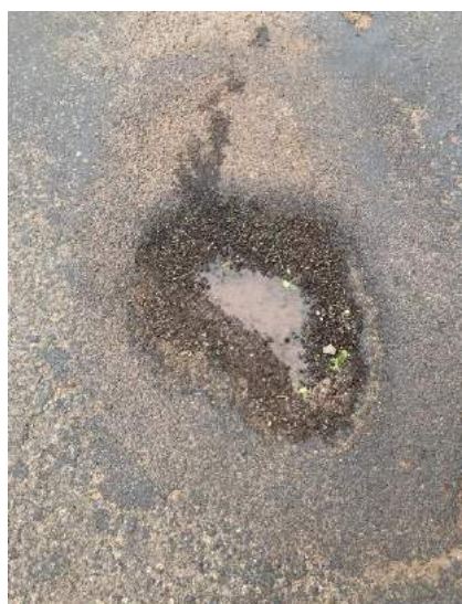
Figura 8 - Abertura de um novo buraco no reparo 4.
