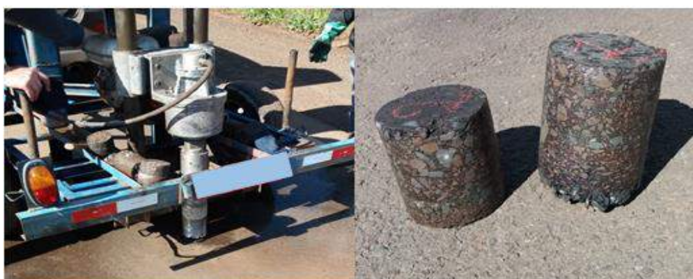
Figura 3 - Sondagem do pavimento para extração de testemunhos
