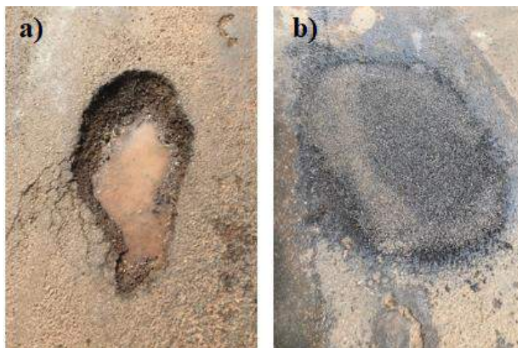
Figura 4 - Panela após um dia chuvoso (a) e reparo compactado (b).
