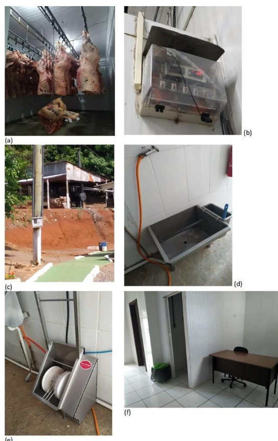
Figura 1 - Ambientes do abatedouro em conformidade: (a) câmaras de refrigeração; (b) controlador de temperatura; (c) caldeira; (d) e (e) lava pés; (f) sala destinada à inspeção.
