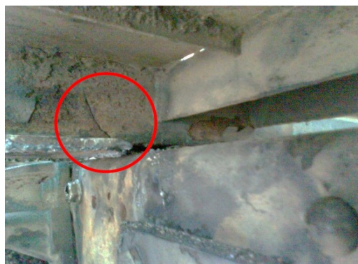
Figura 1 - Detalhe do defeito na travessa de sustentação traseira
