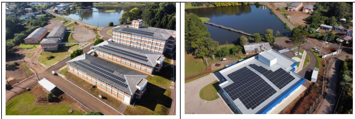
Figura 33: Usina Fotovoltaica instalada no Câmpus II
