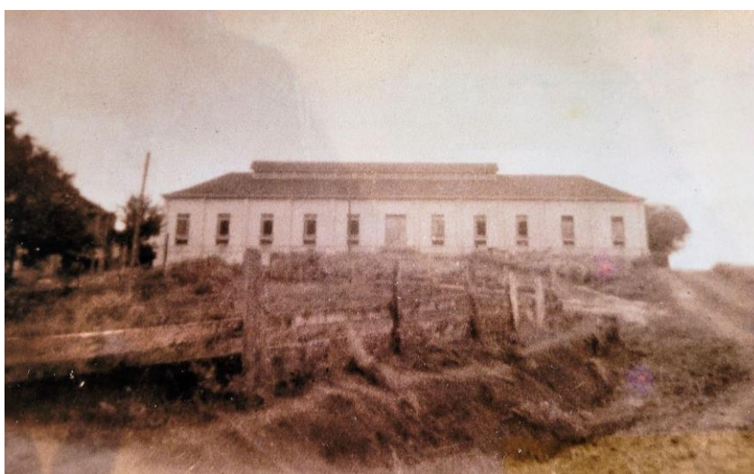
Figura 3: Prédio de alvenaria do Hospital Santa Isabel. Década de 1960
