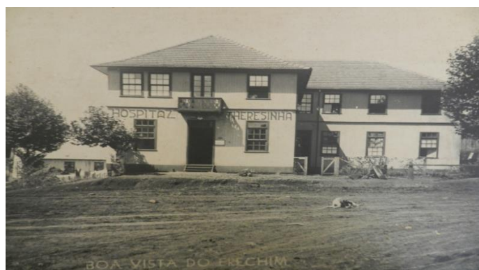
Figura 2: Hospital Santa Terezinha, situado na rua João Massignan, em 1936
