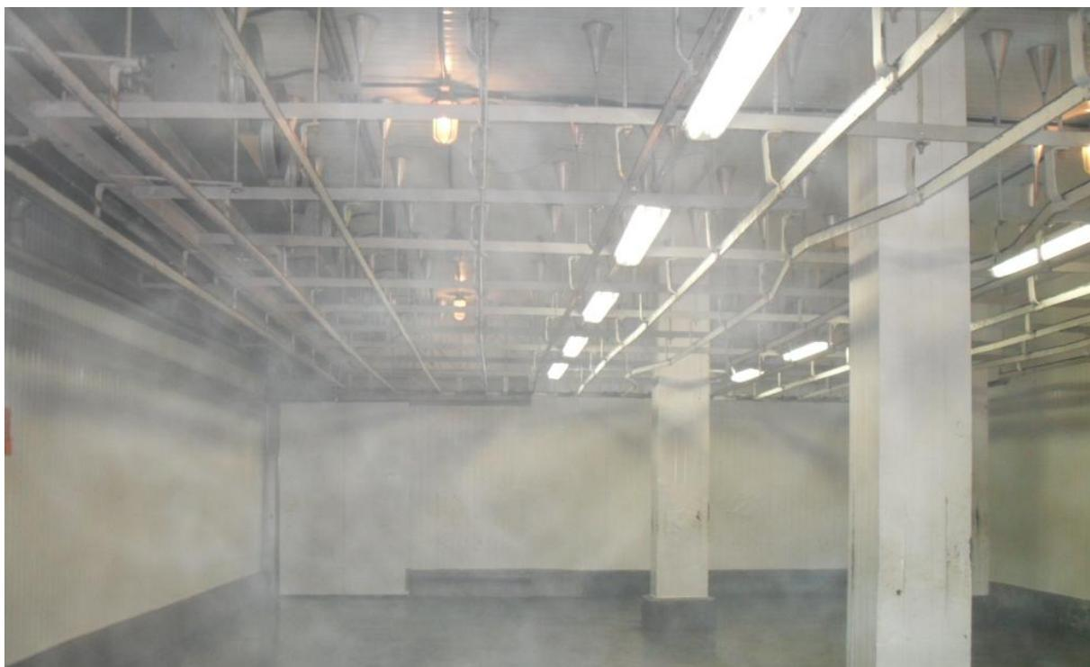
Figura 5 – Câmara de equalização para resfriamento das carcaças.
